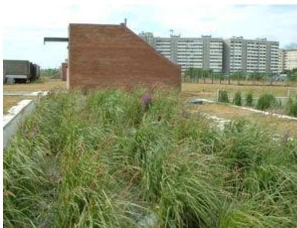
Рис. 2. КНС с ВБО и биоплато очистки загрязненных дождевых, талых вод и вод от мойки транспорта автоцентра «ВОЛЬВО», г. Киев
